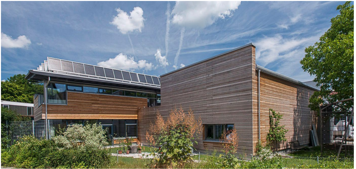
Die Gebäude – Betriebsgebäude (links) und Werkhalle (rechts) – wurden exakt nach Süden ausgerichtet, um die Solarenergie im Winter passiv (über die Fenster) und ganzjährig aktiv (über 100 m 2 Sonnenkollektoren auf dem Dach) optimal nutzen zu können.
