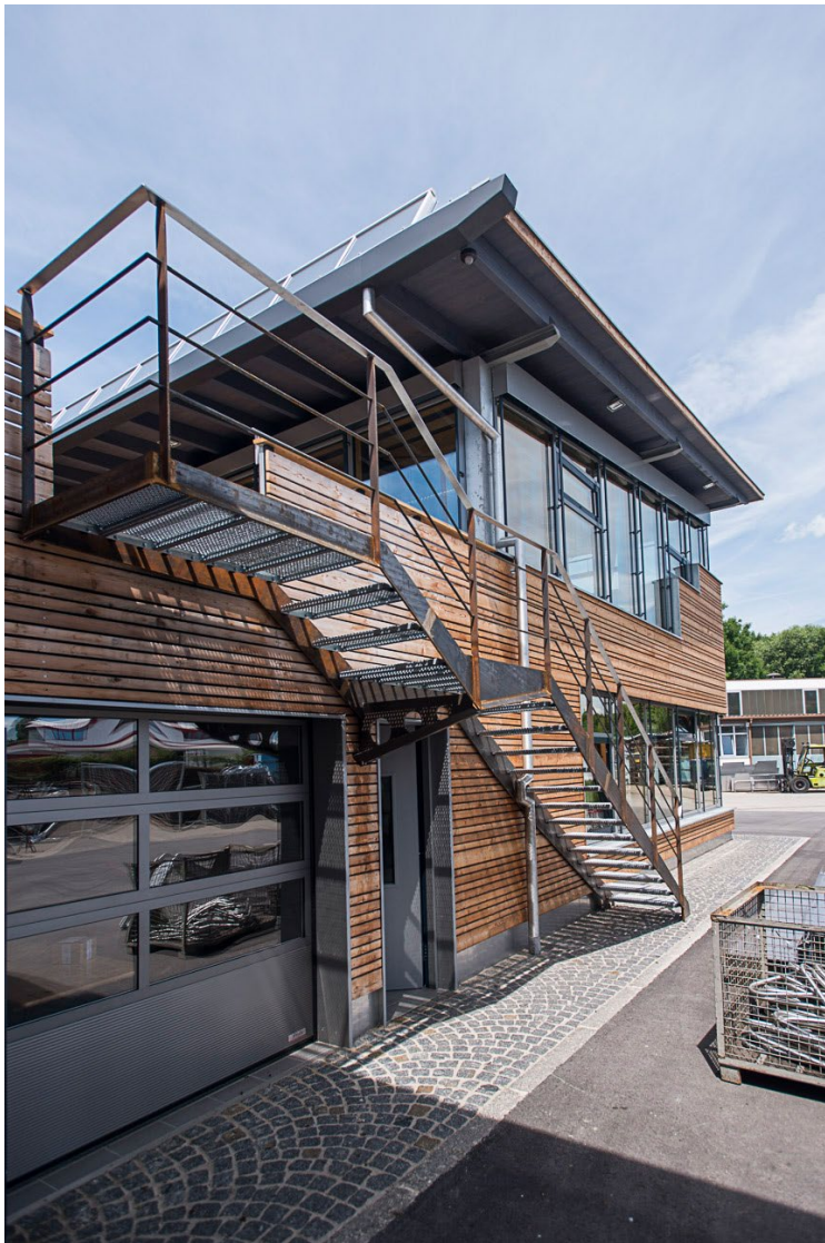
Roh belassene Materialien: schwarzes Eisen und unbehandeltes Lärchenholz. Die Form der Treppenwangen spiegelt die statischen Gegebenheiten wider.
